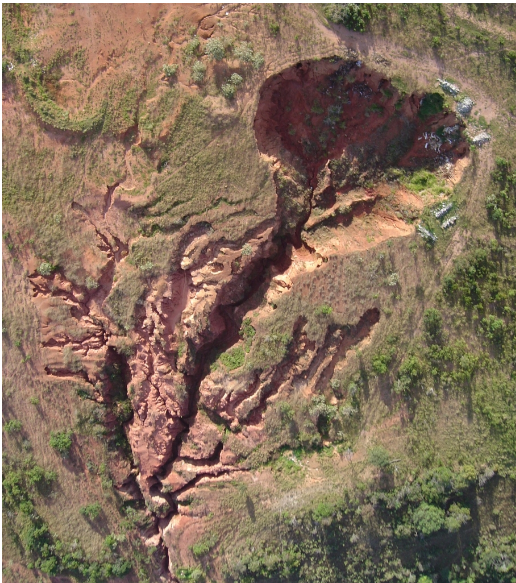
Voçoroca na Fazenda do Glória, em Uberlândia (MG). (Foto: Banco de dados do Laboratório de Geomorfologia e Erosão dos Solos)
